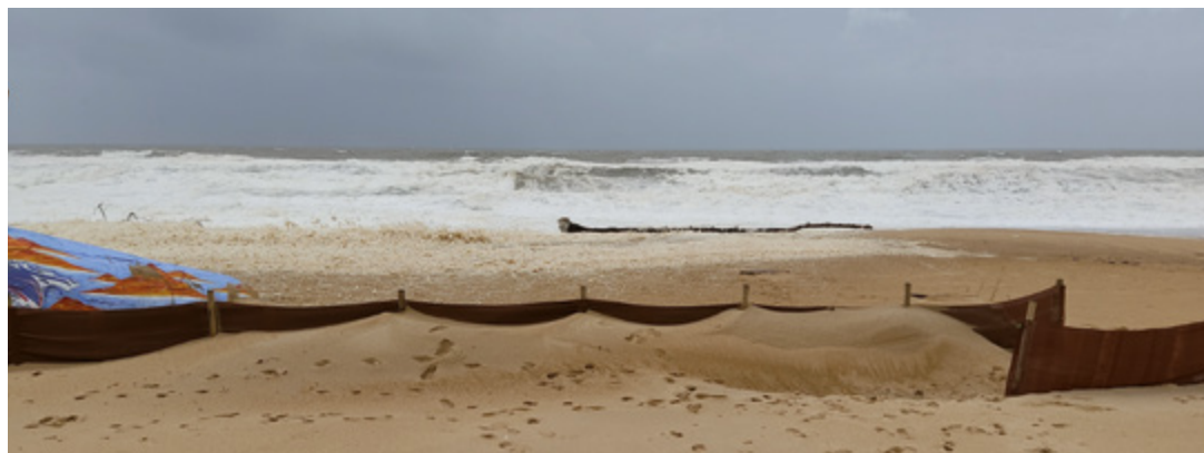
Le sable collecté entre les bâches ne gêne plus les accès à la Plage du Métro. Il est ensuite déposé sur la dune pour la renforcer.
